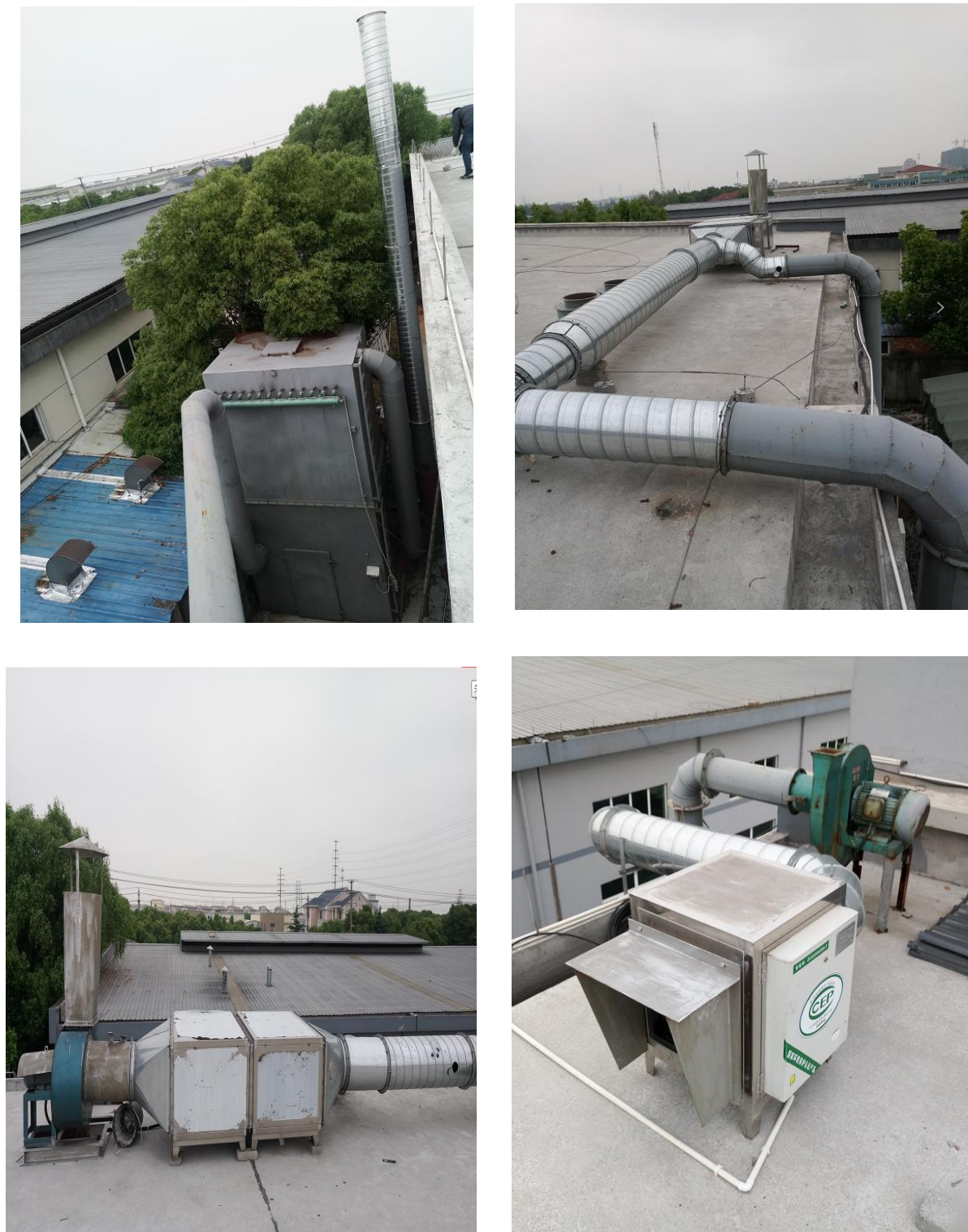
图 4-3 企业废气治理现场相关照片
